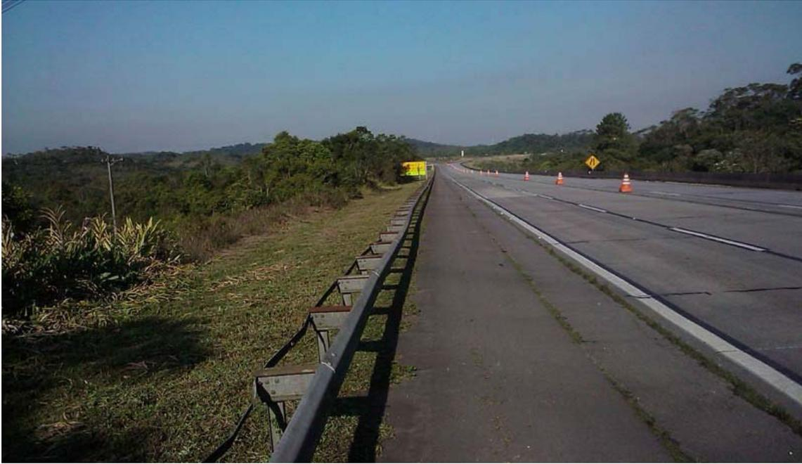
Uma proteção ao ciclista é fundamental, ela pode ser feita com guard-rails ou barreiras de cimento (New Jersey)
